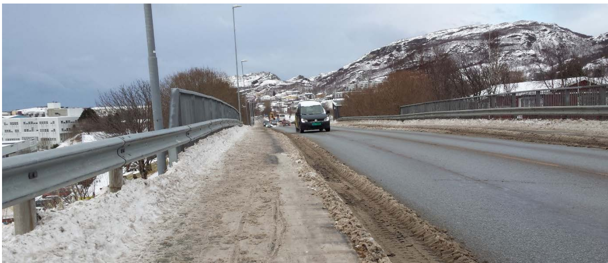
Figur 27: Jernbanebrua. Fortauet er for trangt for brøyteredskapene
