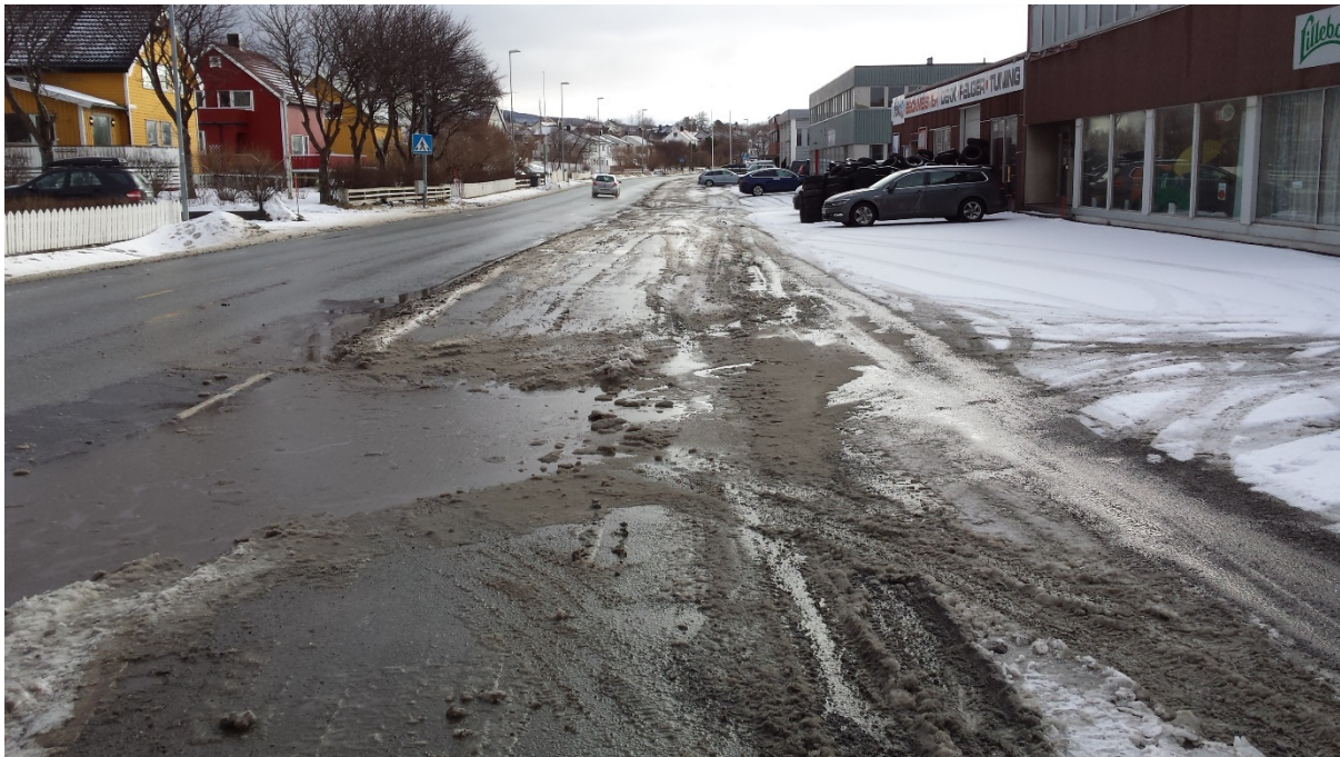
Figur 26: Tilstand på fortau i nordre del en vanlig vinterdag; 10.3 2017 klokken 1000. Det har snødd 2 cm på nattmorgenen, og temperaturen er omkring 0 grader
